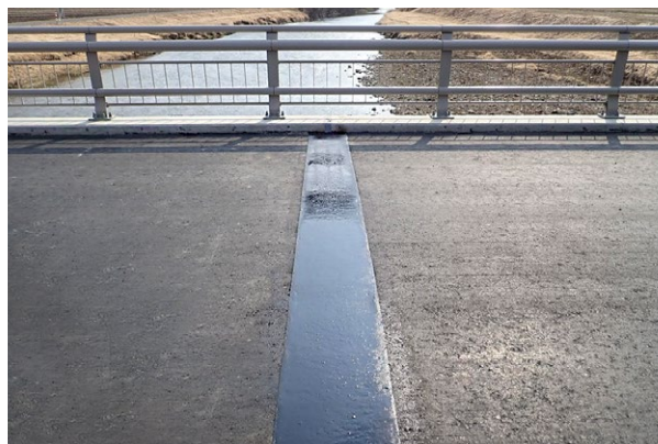
山屋橋（九戸郡九戸村山屋地内）
