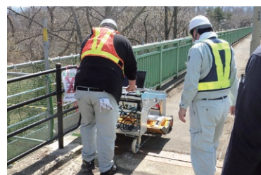
歩道部は手押しタイプで調査を実施
