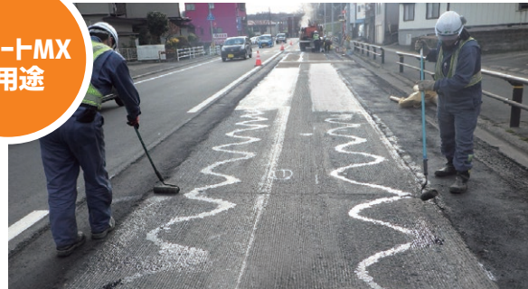
AS舗装(切削面)上の リフレクションクラック抑制シート貼付工
