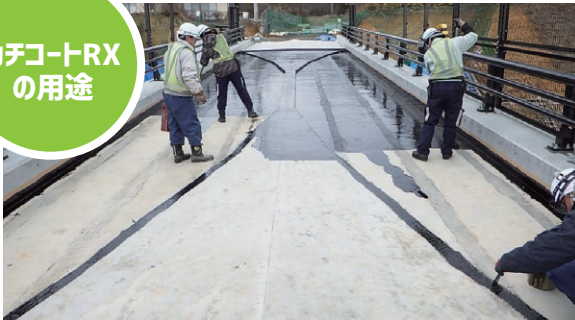
コンクリート床版上の アスファルト防水工
