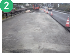
一次防水層完成
