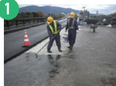
マルチプライマー塗布
