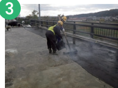
二次防水層 フレッシュコート塗布
