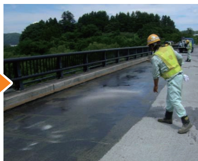
骨材散布状況
