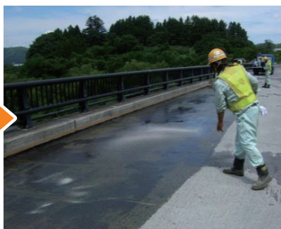
骨材散布状況
