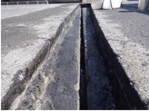
既設舗装撤去
