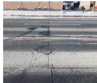
コンポジット舗装構造での 破損事例①
