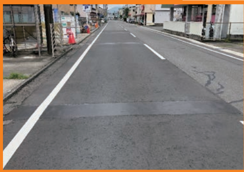
施工事例 ①
