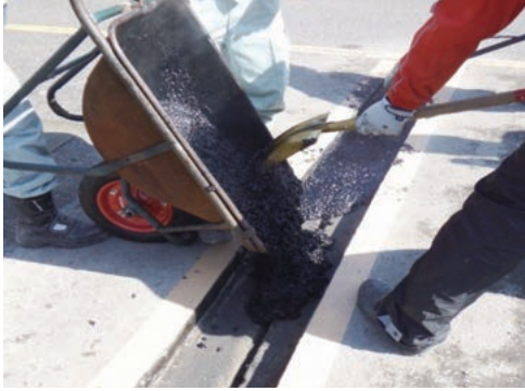
合材流し込み状況
