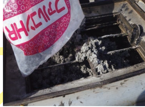
合材投入・溶解状況
